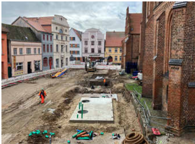
Foto: Blick auf das Fundament der neuen WC-Anlage
